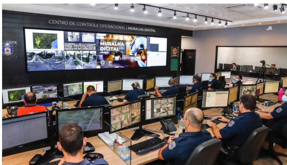
FIGURA 1: CENTRO DE CONTROLE OPERACIONAL (CCO).
