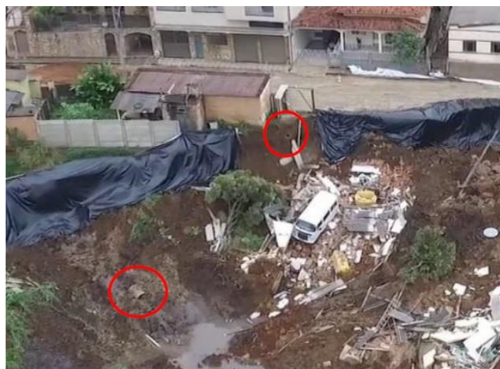
Figura 7. Escombros com manilhas de concreto rompidas e solo escuro sobre logradouro (CPRM, 2017).
