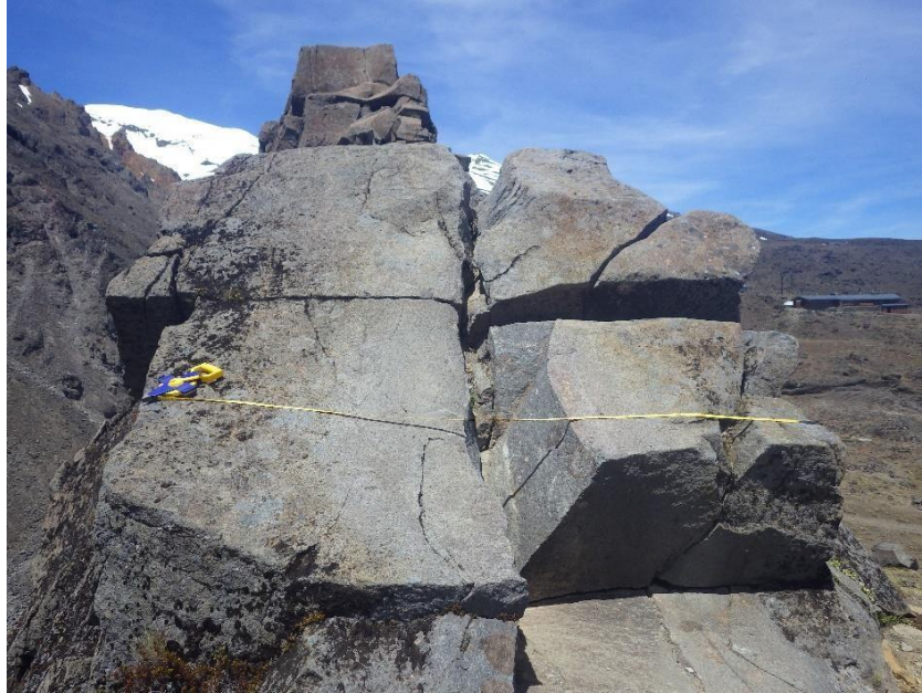
Figura 24 - Fotografia do dique superior (Figura 15), com aproximadamente 1 metro de espessura, dando ênfase a abertura das fraturas em partes menos alteradas do dique.
